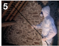
5 Pulvérisation du produit de traitement de bois D'XYL sur l'intégralité de la charpente
